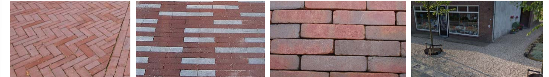
Klinkerverharding weg, keperverband, Pad naar rivier, halfsteensverband, Pad naar rivier, halfsteensverband, doorzetten op aangegeven andere plaatsen op Grindverharding bestaand, doorzetten van blauwe klinkers
